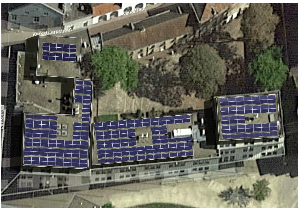
Legplan zonnepanelen op het dak van het bestuurscentrum Meerssen
